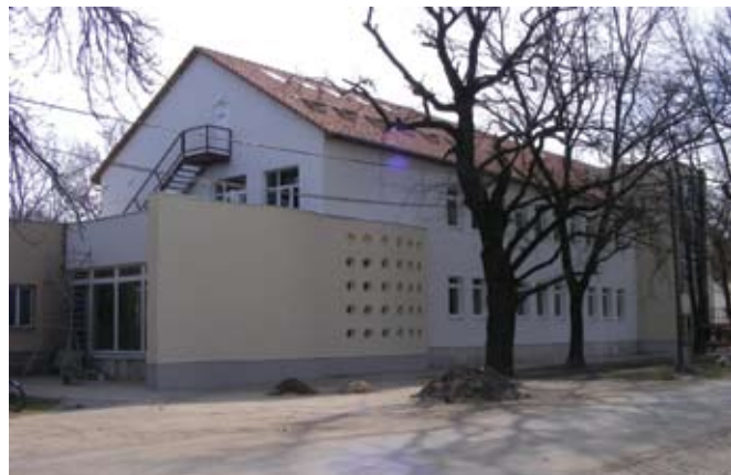
A felújított, volt gimnázium épülete
